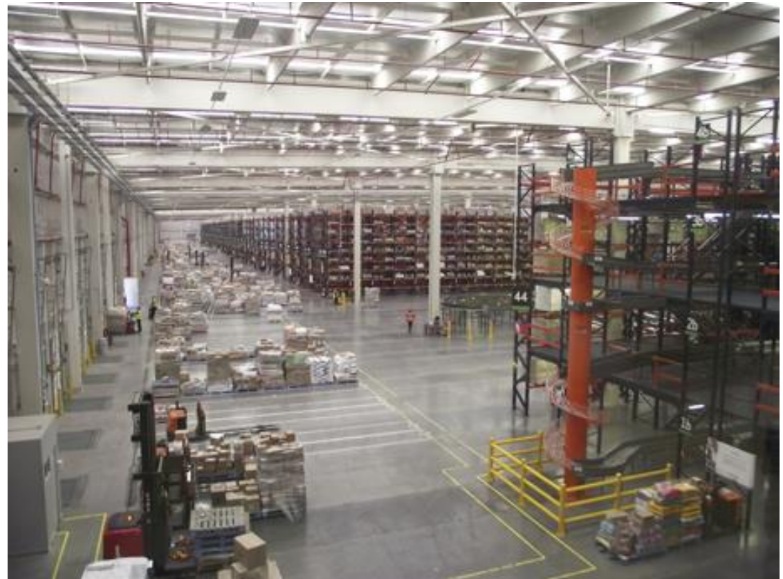
Centro de Distribución Unimarc Santiago
