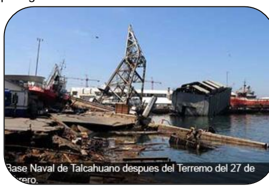
Grúa de 180 T y dique en la Dársena
