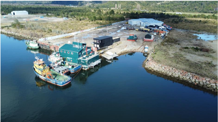
Muelle Calderón – Puerto Aysén.
