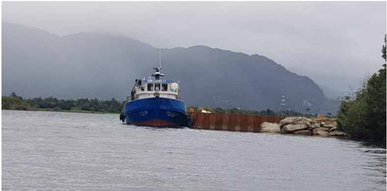
Muelle LAFQUÉN – Puerto Aysén
