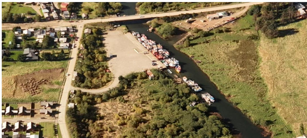
Vista General Muelle Fiscal Aguas Muertas
