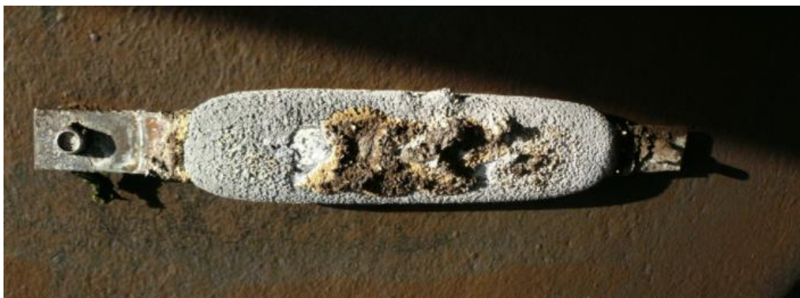
Figura N°3: Ánodo de sacrificio
