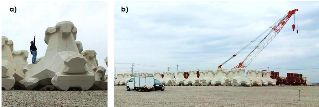
Ilustración 89: Elementos de hormigón en fase de construcción para un rompeolas en el puerto de Misaki, Japón. a)
