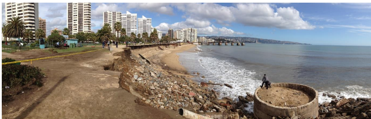
Ilustración 93: Socavación del paseo costero en Playa El Sol producto de la marejada del 8 de agosto de 2015 (Winckler et al., 2017).
