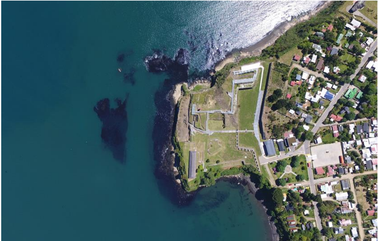
Ilustración 69: Fuerte de Niebla, en la desembocadura del río Valdivia.
