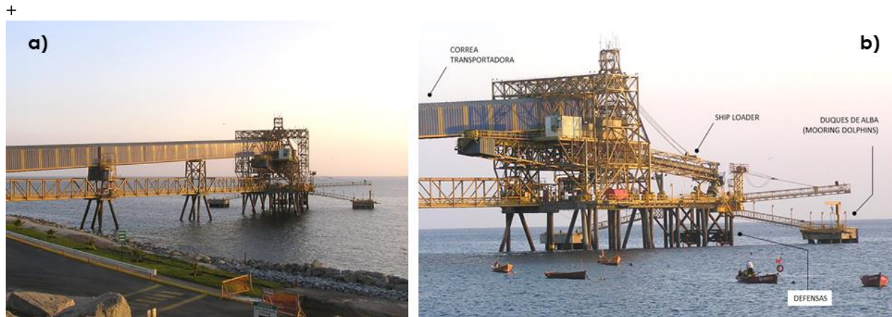
Ilustración 78: Muelle mecanizado de atraque para buques graneleros en el Terminal Coloso, al sur de Antofagasta. a) Vista de la correa transportadora y pasarela de acceso. b) Detalle del cabezo donde atracan naves de hasta 200 [m] de eslora y 12 [m] de calado.
