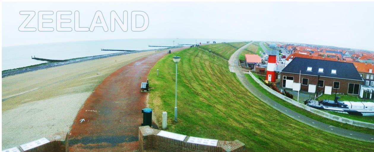
Ilustración 95: Dique de protección de la ciudad de Westkapelle, en Zeeland, Países Bajos.
