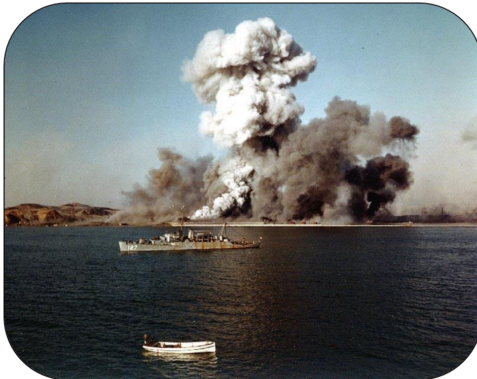
Destrucción del puerto Hungnam 24 diciembre 1950. USS Begor (APD-127) zarpa a Corea del Sur 73
